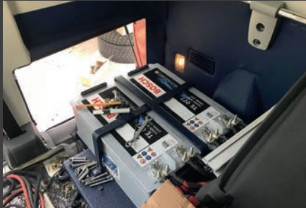
▲ Akut kiinnitettiin paikoilleen asiaankuuluvilla osilla.
